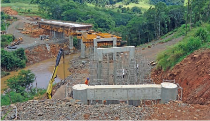
\ Ponte sobre o rio Estreito, Brasil
