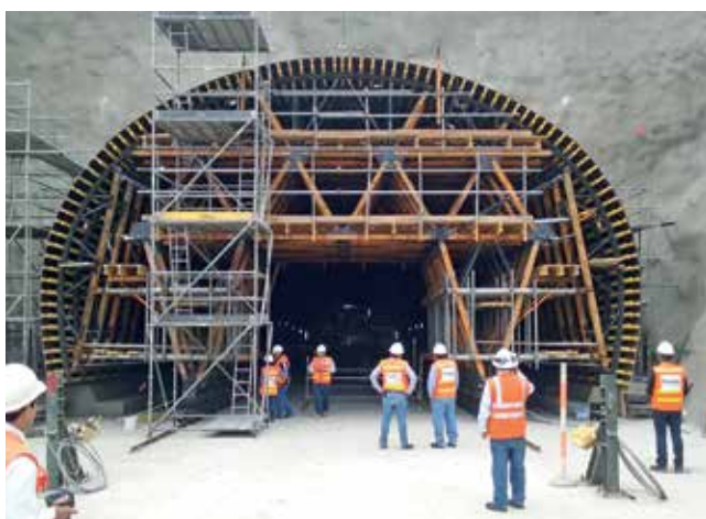
Túnel Santa Rosa, Peru
